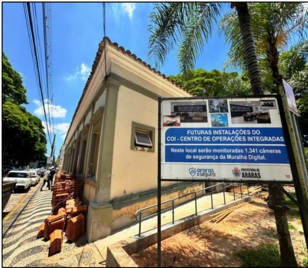
Figura 2 – Casa do Artesão de Araras, São Paulo
