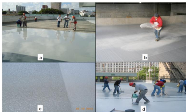
Figura 3- Aplicação das Camadas de Poliuretano
